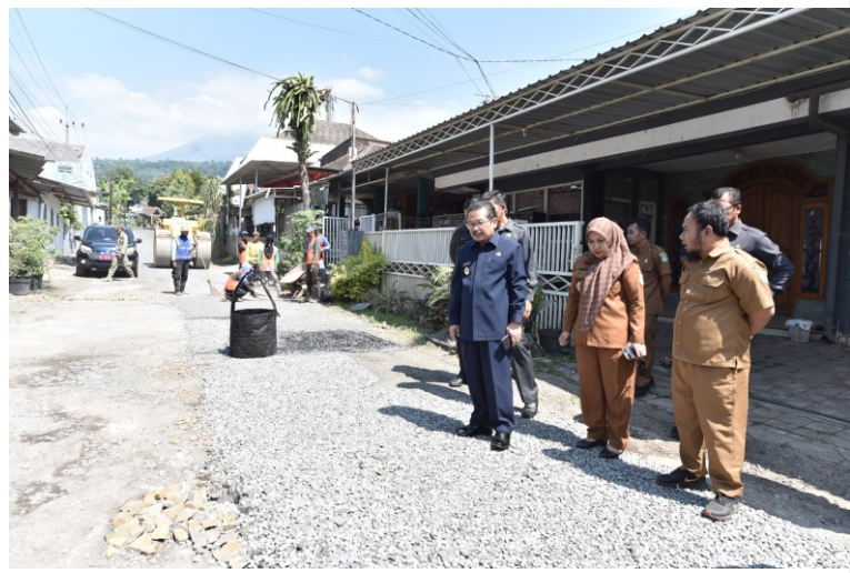
Proses pengerjaan perbaikan jalan dipantau oleh Pj. Bupati Pasuruan, Andriyanto. Tepatnya setelah menghadiri acara di salah satu hotel di wilayah Kecamatan Prigen
